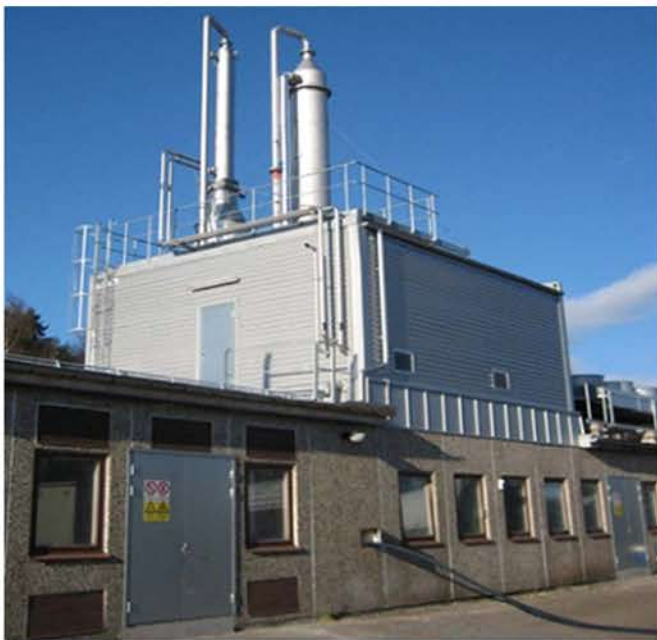
شکل ۱۱: نیروگاه ارتقاء بیوگاز به روش جذب شیمیایی در گوتنبرگ سوئد با ظرفیت بیوگاز خام m^3/h
