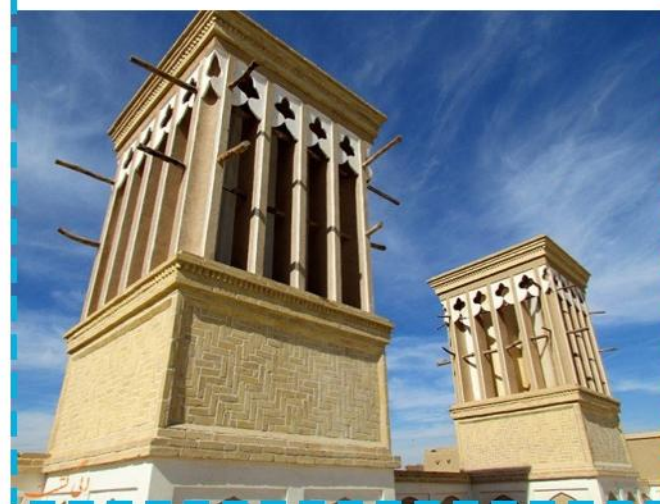
شکل ۳. بادگیر چهار طرفه و شماتیک عملکرد آن
