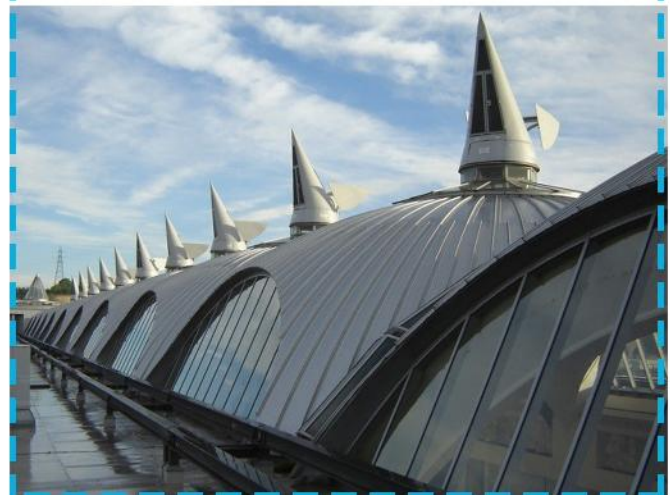
شکل ۵. بادگیرهای نصب شده در مرکز فروش بلوواتر
